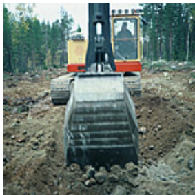
Grovbrytning och terrassering
