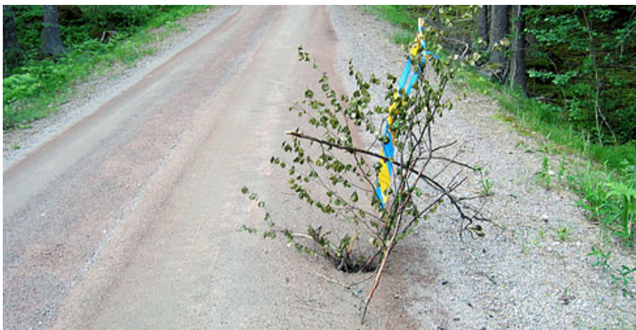
Tjälskott kan vara djupa skador som är en klar trafikfara. Foto Skogenbild.
