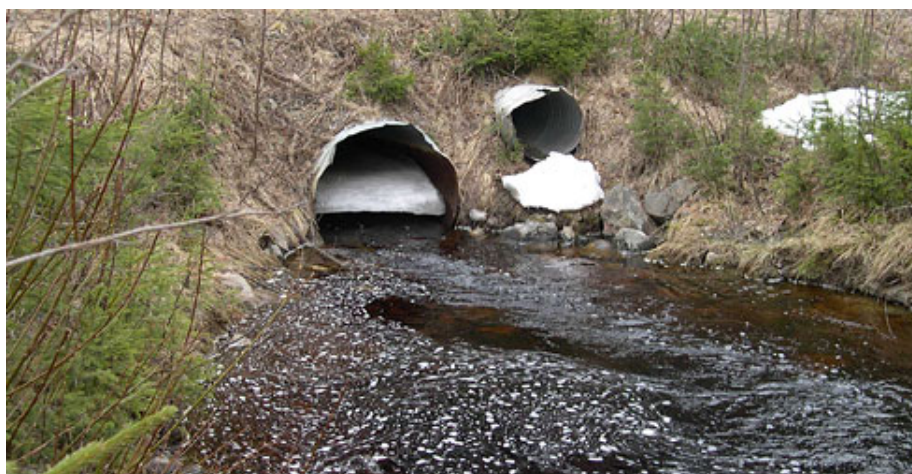
Den övre trumman fungerar som ett bräddavlopp när vattnet står högt och den undre trumman är igenisad. Foto Skogforsk.
