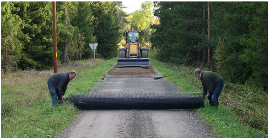
Utläggning av bärighetsförstärkande geonät. Foto Skogforsk.
