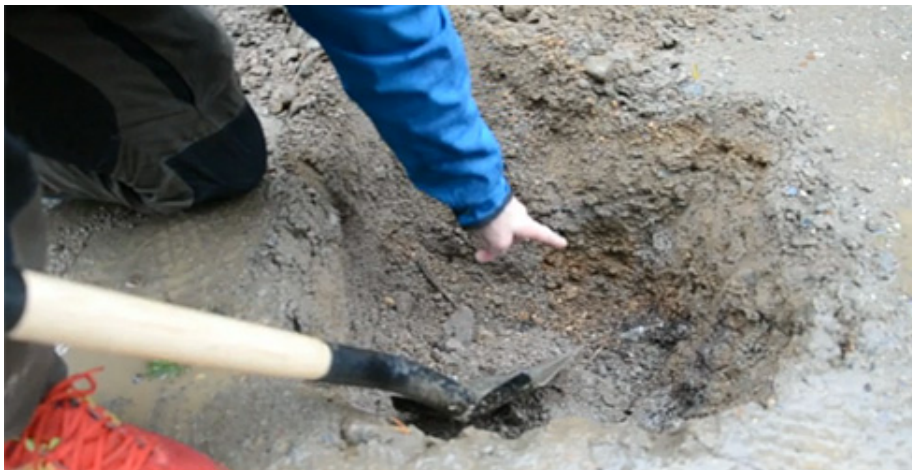
Förstärkningslagret ligger i botten av överbyggnaden och täcks av bär- och slitlager. Foto Per Hallgren.
