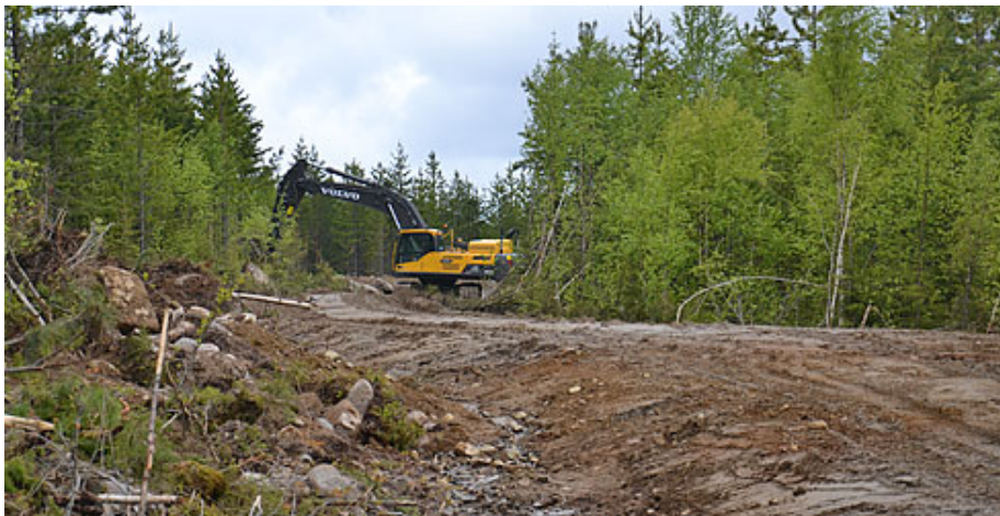
Slutjusterad vägterrass. Foto Per Hallgren.
