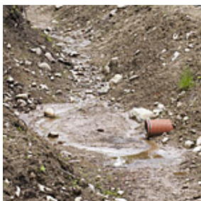
Diken och dikesslänter
