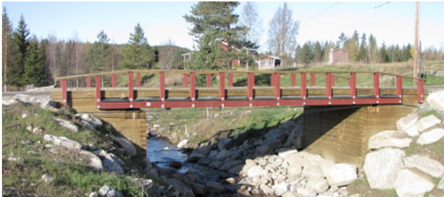
Tvärspänd plattbro. Foto Per Hallgren.
