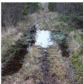
Förstärkning av vägbanken
