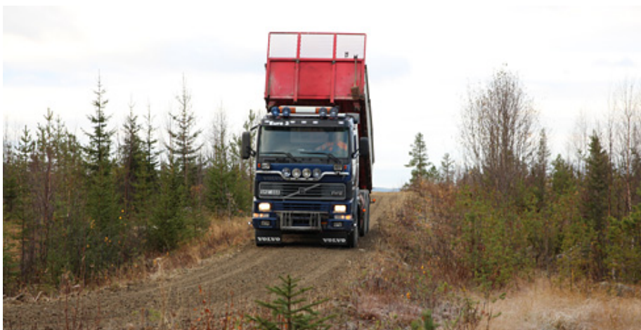
Kompletteringsgrusning är en viktig åtgärd. Foto Mats Hannerz.
