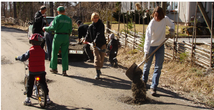
Flickning kan göras för hand, och kan passa för tillfälliga reparationer av ojämnheter. Foto Mats Hannerz.
