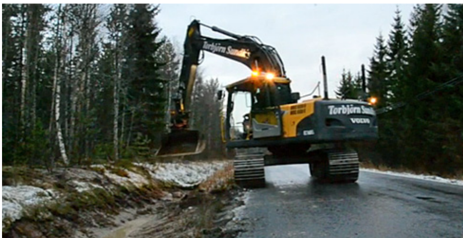
Dikning med planeringsskopa. Foto Per Hallgren.
