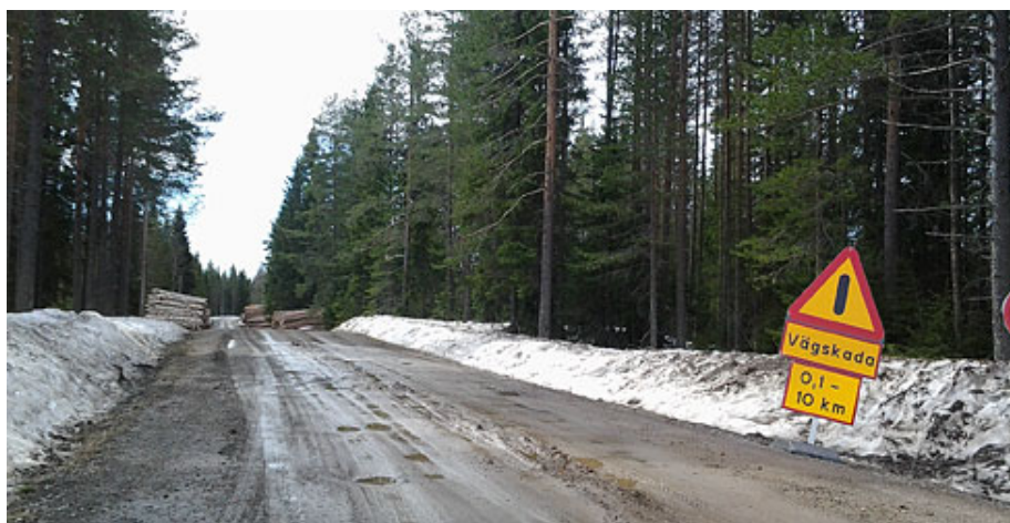
Vägskada vid tjällossning. Foto Per Hallgren.
