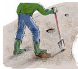
Flickning kan göras för hand, och kan passa för tillfälliga reparationer av ojämnheter. Foto Mats Hannerz.
