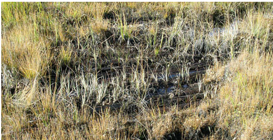
Resterna av en äldre kavelbro av kvistiga stockar på en myrmark. Foto från Wikipedia commons (Taxelsson).
