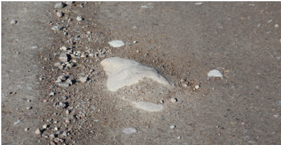
Uppträngande stenar kan behöva rensas bort innan hyvlingen. Foto Mats Hannerz.
