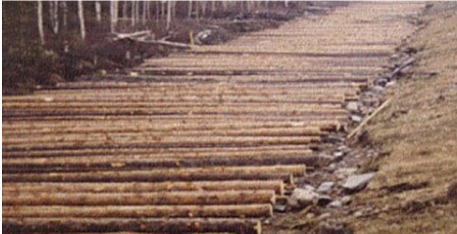
En stockmatta kan användas som tryckfördelare, här har den använts för att bredda en väg på fuktig mark. Foto Forestry Commission, Skottland.
