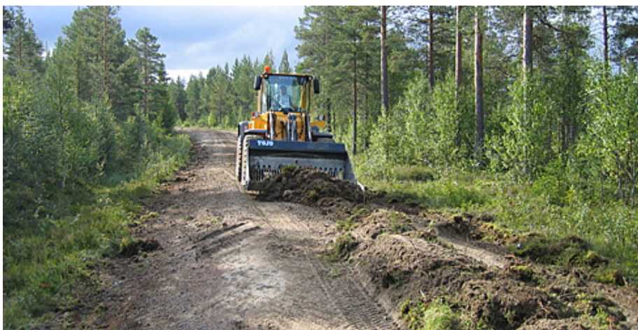
Grusåtervinning med gallerskopa, en äldre metod. Foto Sveaskog.
