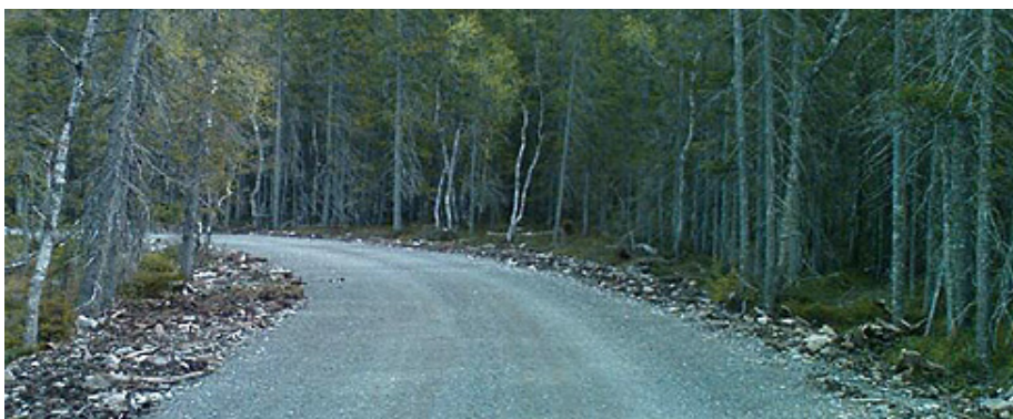
Väg dragen på torvmark med 3 meters djup. Vägen är byggd på flytande bank. Foto Per Hallgren.
