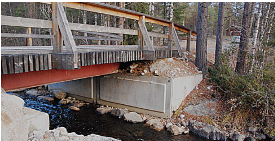
Stålbalksbro. Foto Per Hallgren.
