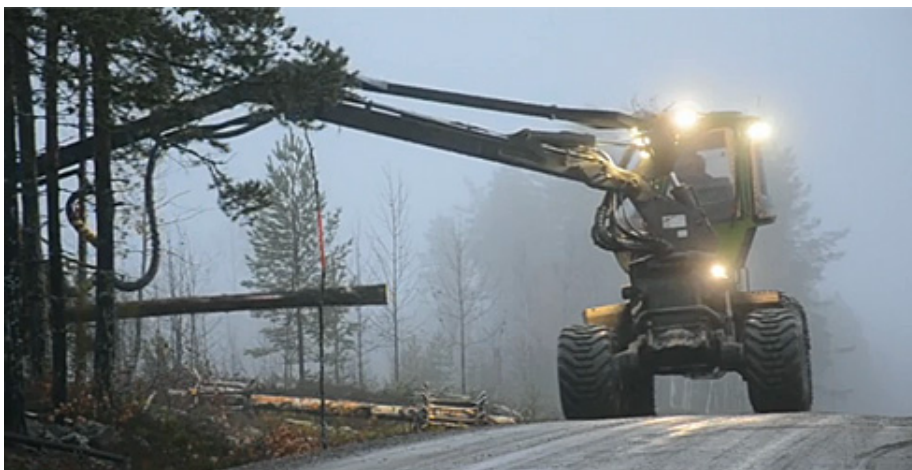
Vägen vinner på att röjas, åtminstone 2 meter utanför dikesslätten. Foto Per Hallgren.
