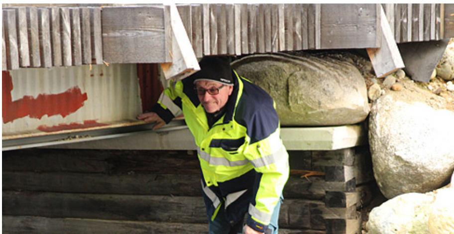
Brobesiktning, en regelbunden och nödvändig åtgärd. Foto Mats Hannerz.
