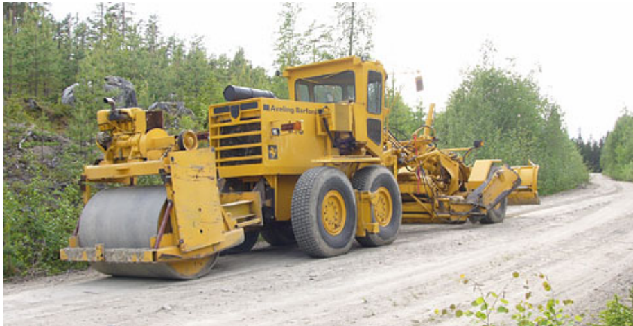
Packning med vält. Foto Fredrik Staland.
