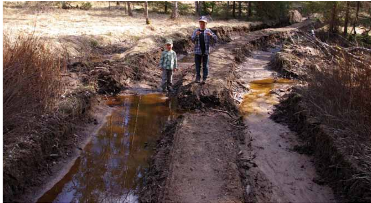
Bäcken har passerats utan att åtgärder vidtagits för att förhindra att det bildades spår som mynnar rakt i bäcken, med kraftig slamtransport till följd.
