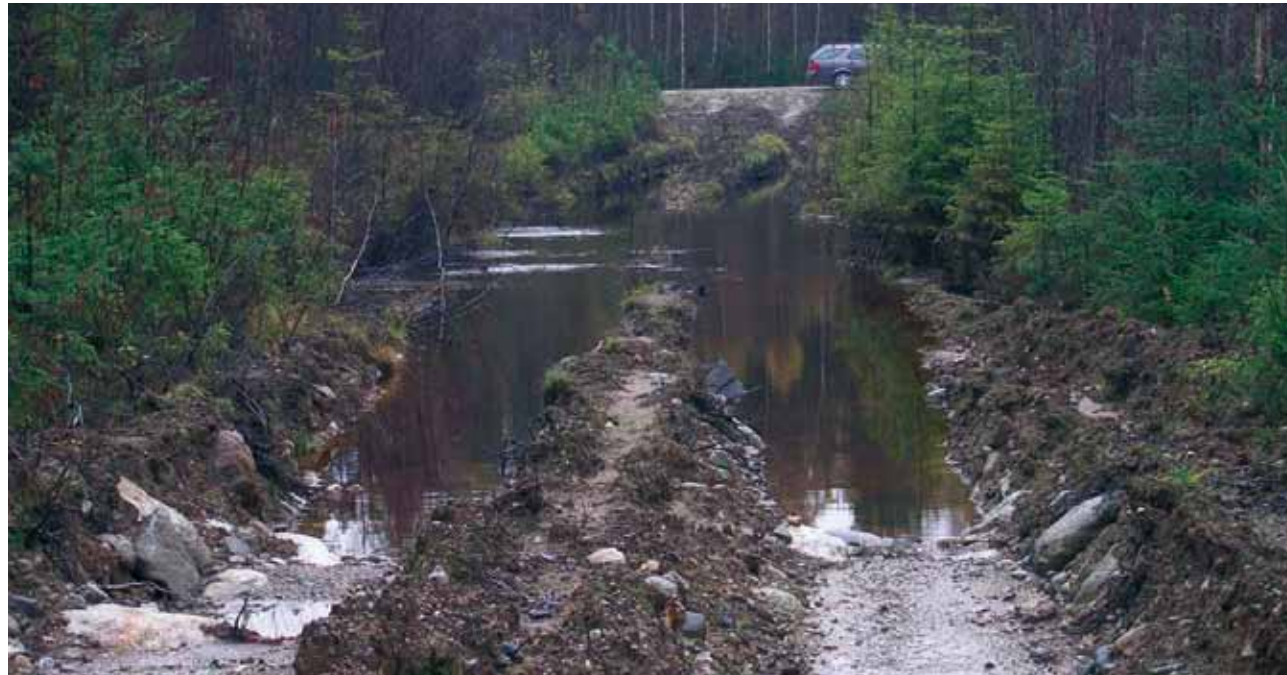
Hjulspåren har orsakat dämning av en bäck.
